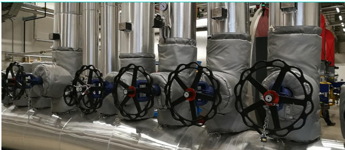
1. ábra: Bevarrt paplanos, eltávolítható ipari hőszigetelés (forrás: Dynotek)
